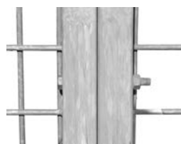
ボルト接続部
